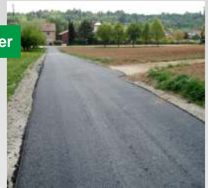
Fertige neue Straße mit Asphaltbelag auf verfestigtem Unterbau
